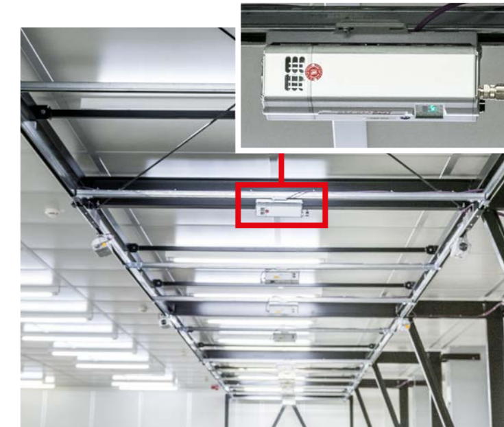
Les projecteurs laser LAP CAD-PRO sont installés au plafond, au-dessus des postes de stratification. Le système est configurable pour des pièces de différentes tailles. Elles sont amenées sur des tables mobiles jusqu'à la zone de projection.
